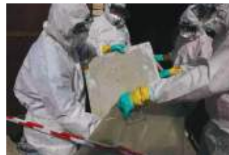
RETIRO DE ASBESTO
