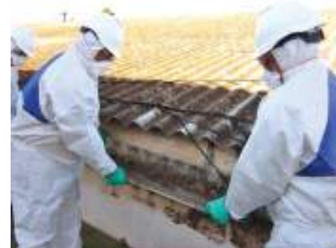
RETIRO DE ASBESTO
